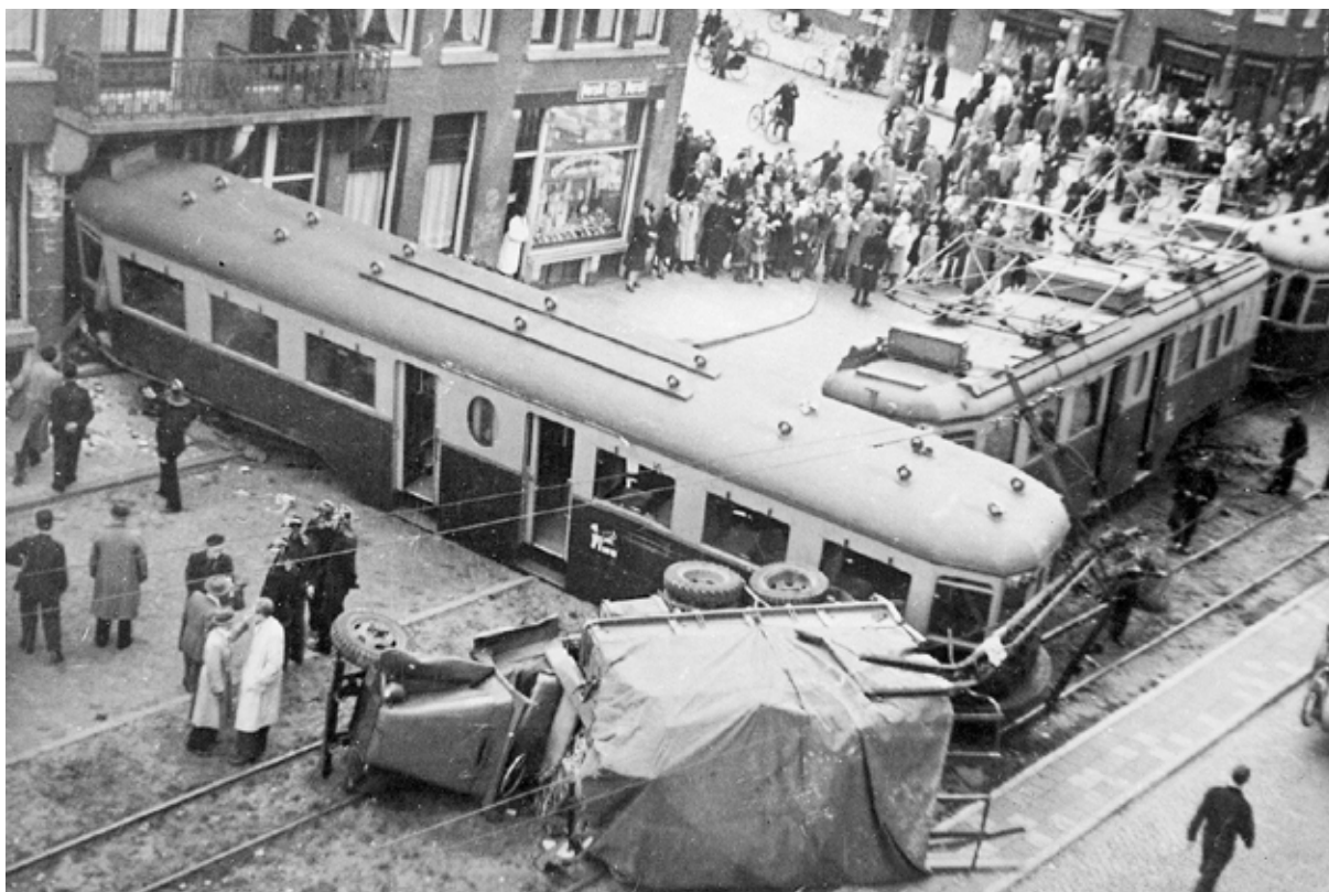
Stuurstandrijtuig B 452 tegen de voorgevel van het pand Admiraal de Ruijterweg 159 te Amsterdam.
