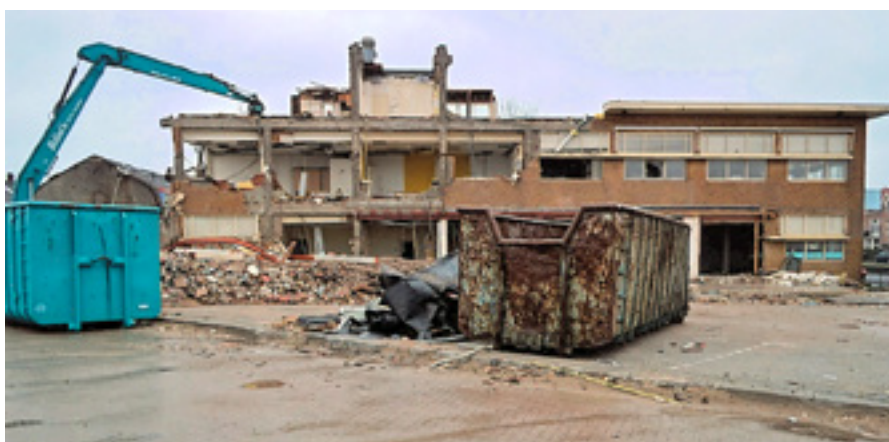
Sloop van het NZH-hoofdkantoorgebouw.
