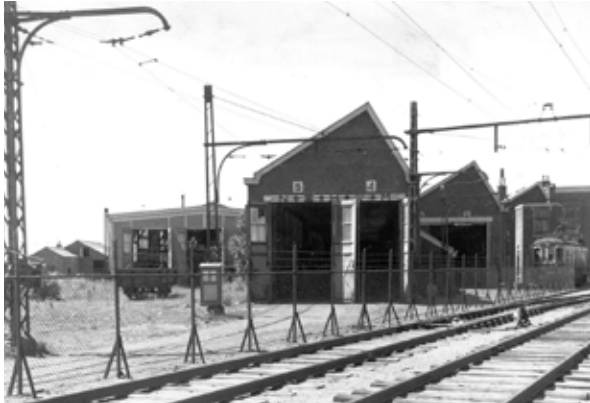
Werkplaats Rijsburg met rechts nog net zichtbaar de H 303.
