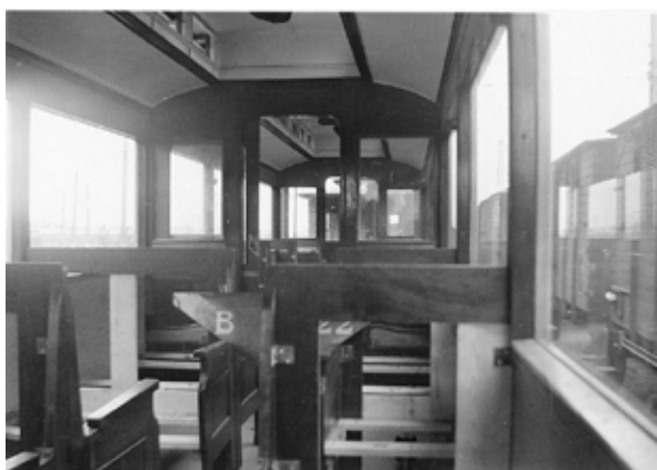
Verbouwing van het interieur in de NZH-werkplaats Rijnsburg.
