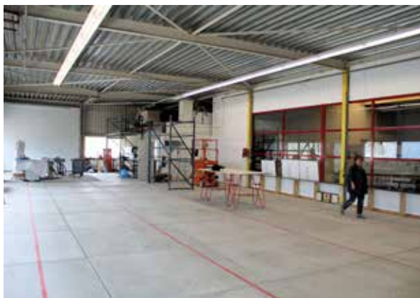
De ruime hal/werkplaats met links de nieuwe aangebrachte roldeur.
