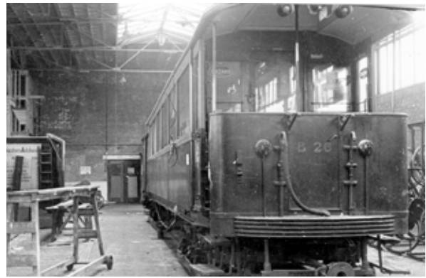
B 26 ingericht als schilderswerkplaats en magazijnwagen, remise Leiden, 27 maart 1959. (Buitendienst november 1950).
