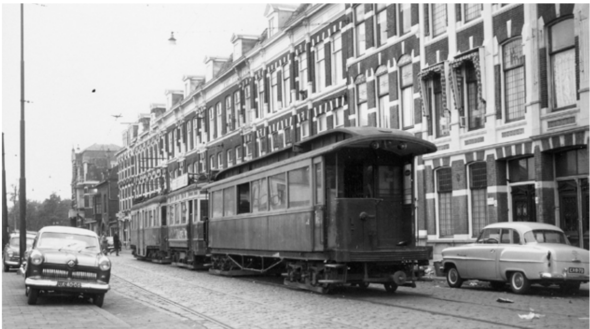
Oponthoud door geparkeerde auto's op de Schenkweg in Den Haag. Het konvooi gaat vervolgens op weg naar het Malieveld. Na het omlopen keert men terug op de Schenkweg om de A 327 en de B 26 dichterbij het hek en emplacement van het Station Den Haag-Staatsspoor te kunnen afzetten.
