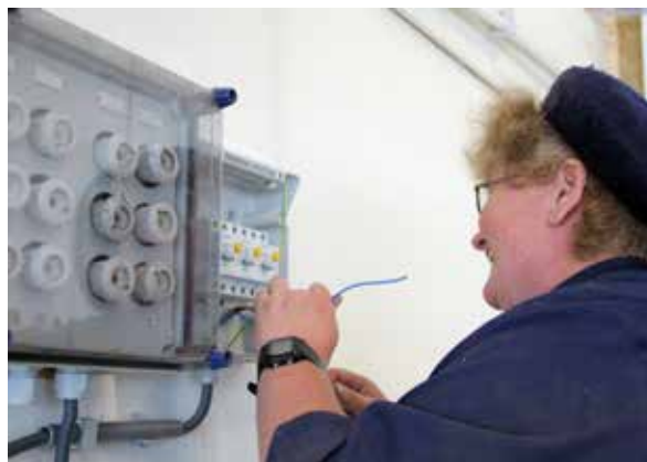
Josina aan de slag met de elektravoorziening.
