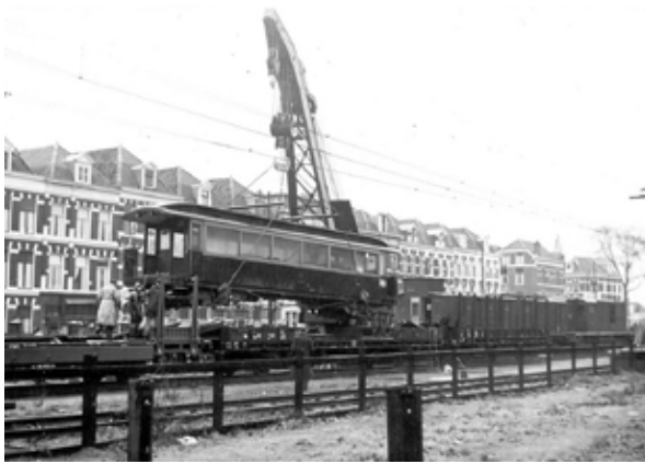
De B 26 wordt op een goederenwagen geplaatst.
